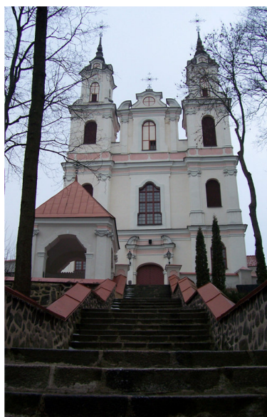
Kościół kalwaryjski p.w. Znalezienia Krzyż Św. zbudowany w latach 1755 - 72
